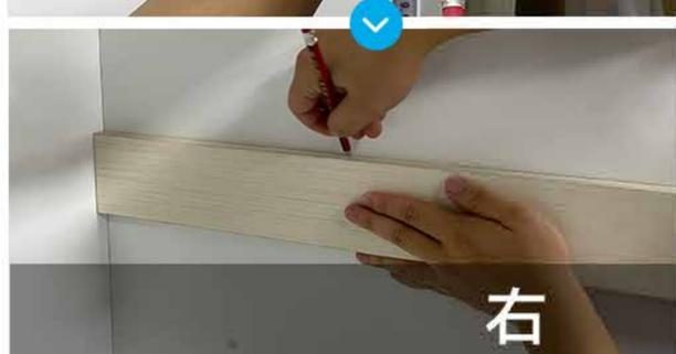
在柜体左右两侧同高度打点
