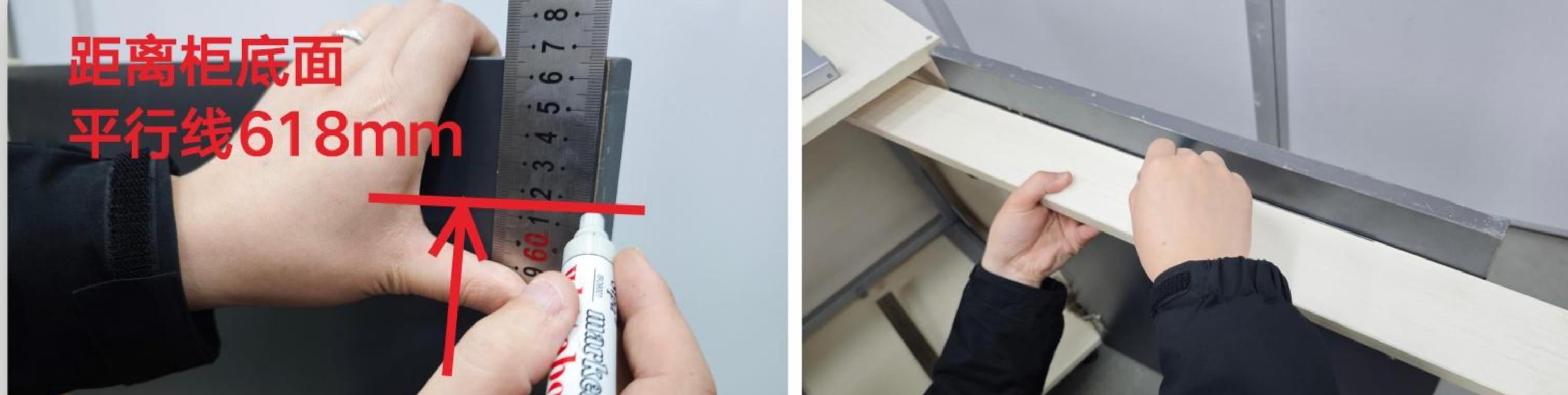
距离柜底面平行线618mm处画柜门第二条基准线。
