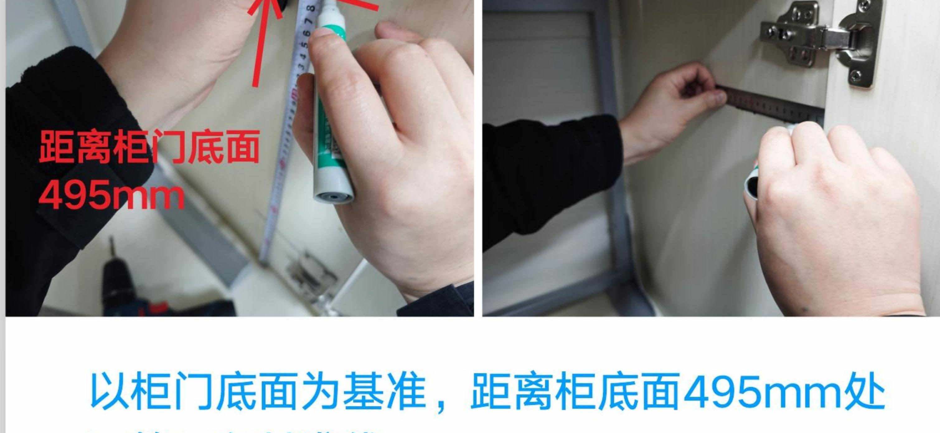
以柜门底面为基准，距离柜底面495mm处画第二条基准线。
