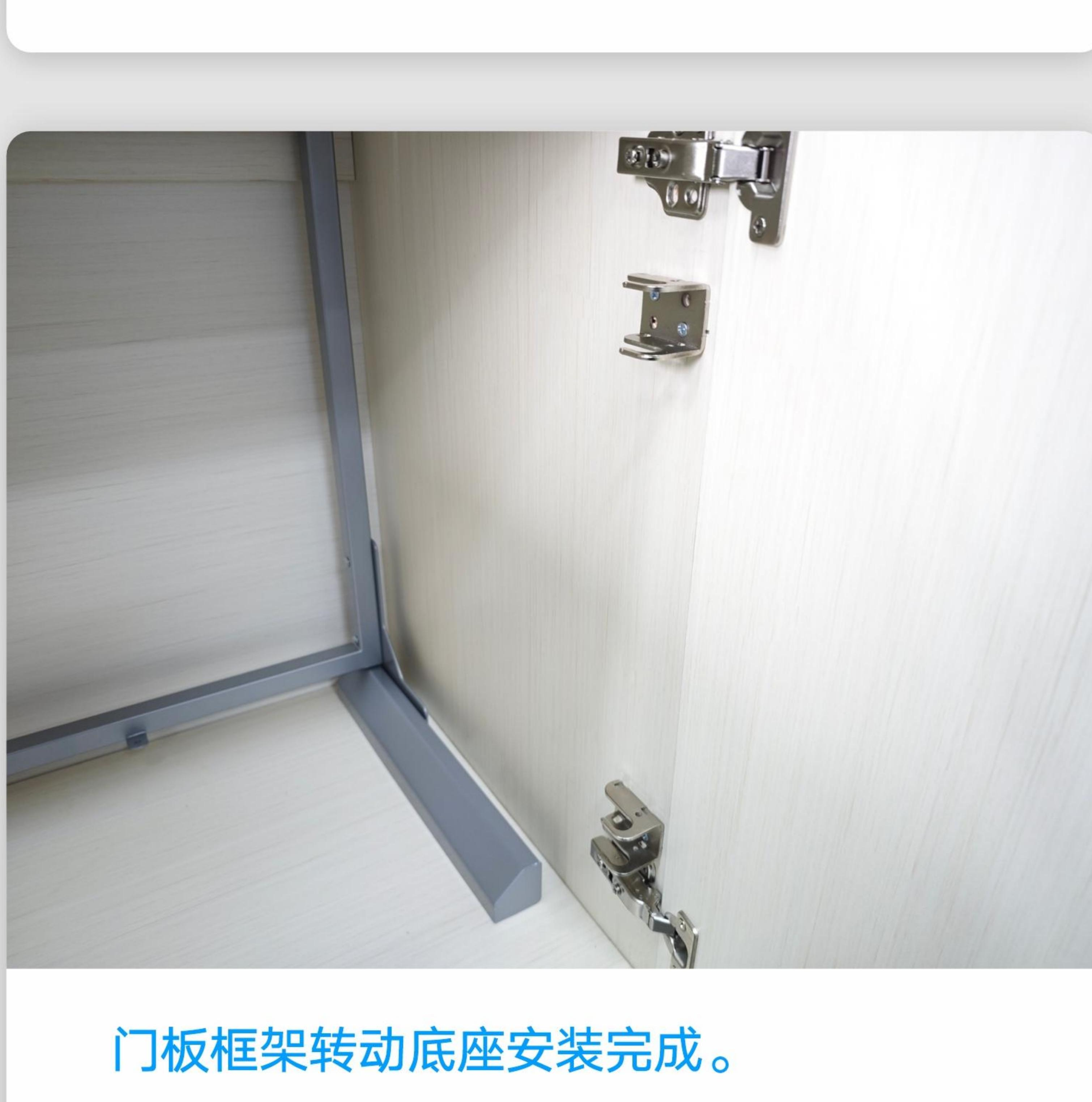
门板框架转动底座安装完成。
