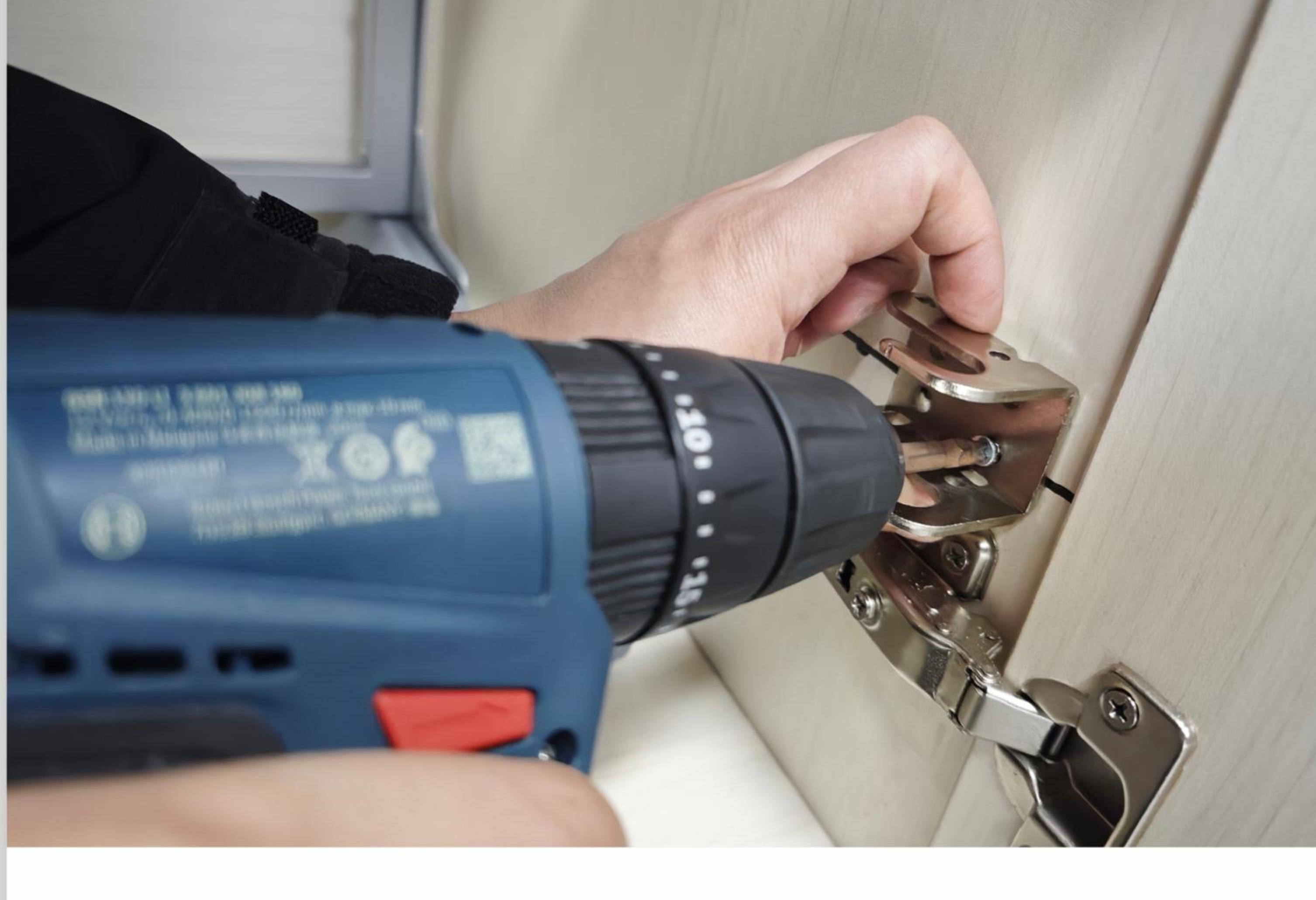
在第一条基准线上，距离柜边21mm处确定基准点，使用ST4.0\*16自攻螺钉对准基准点固定下部转动底座。
