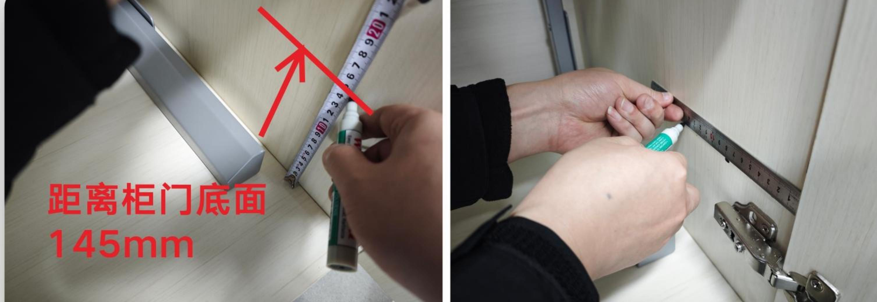
以柜门底面为基准，距离柜底面145mm处画第一条基准线。
