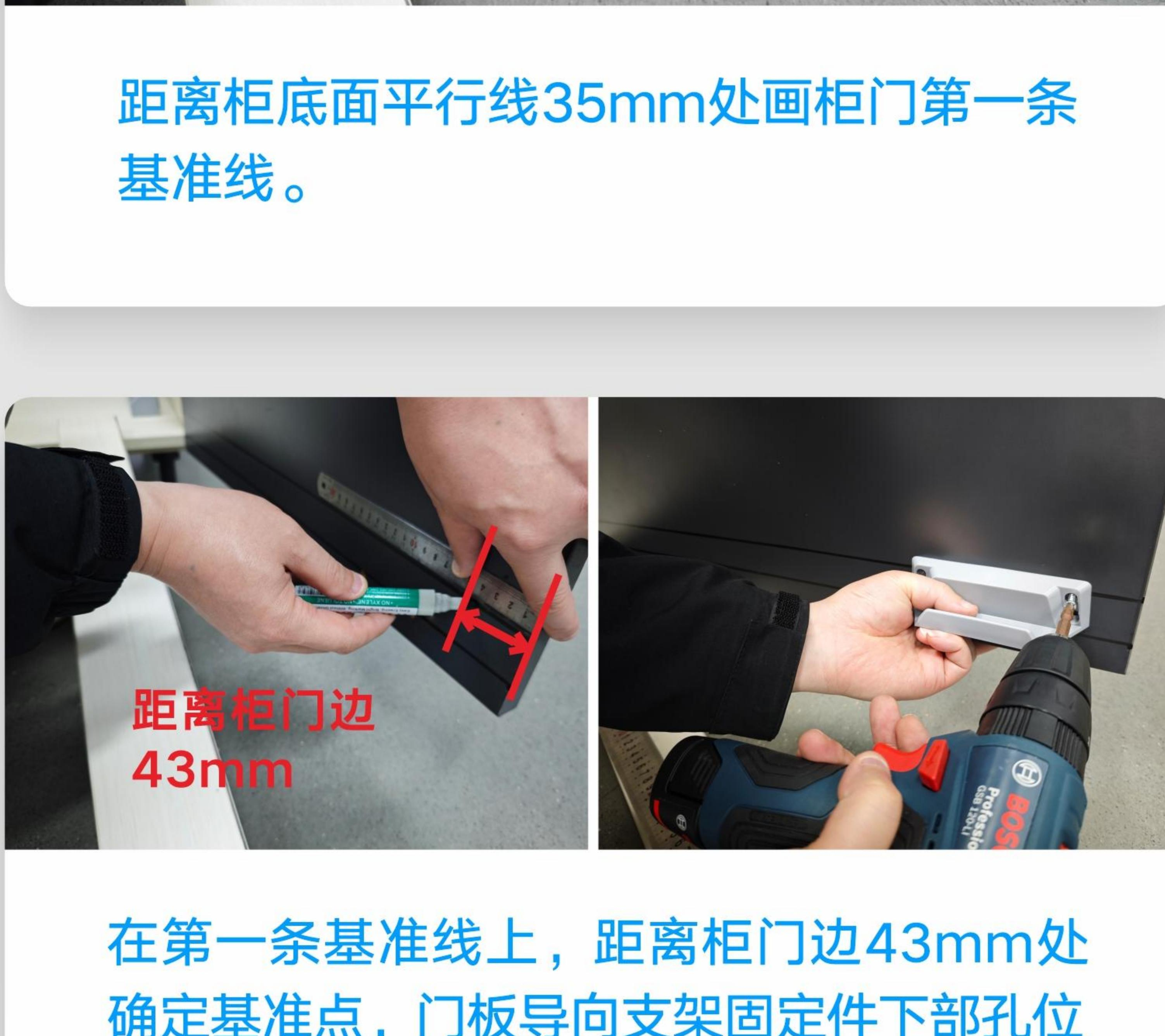
距离柜底面平行线35mm处画柜门第一条基准线。
