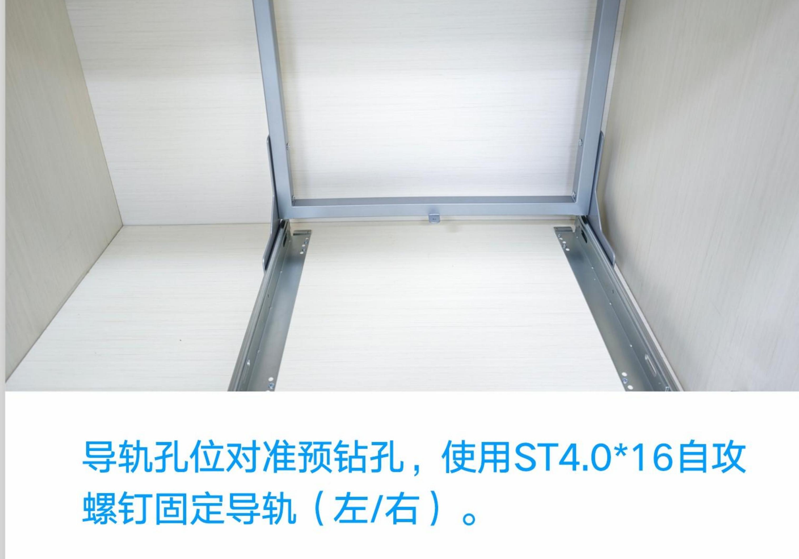
导轨孔位对准预钻孔，使用ST4.0\*16自攻螺钉固定导轨（左/右）。
